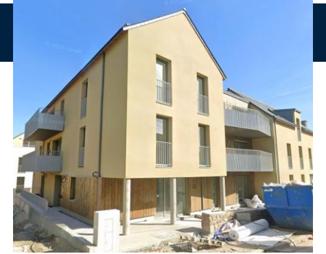
Construction de petits logements en renouvellement urbain à Montfort-sur-Meu
